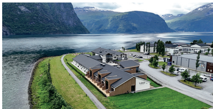
Nybygget har grunnflate på 700 kvadratmeter og inneholder 16 hotellrom og et konferanse- og selskapslokale.
